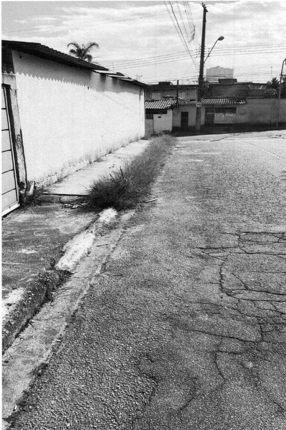
CAPINAÇÃO DE CABEÇAS DE GUIA E RASPAGEM DE SARJETA EM TODA A EXTENSÃO DA TRAVESSA MADEIRAS, VILA CINTRA - MOGI DAS CRUZES.
